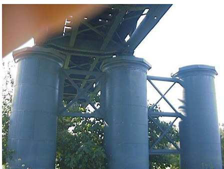
Pilares puente Alcolea de referencia
